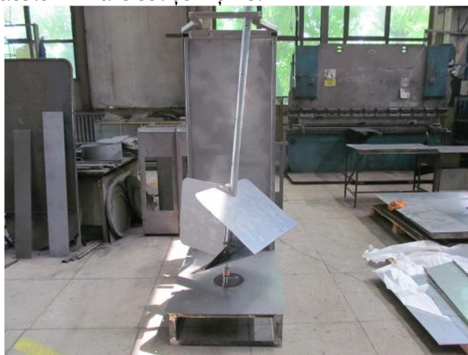
Fig. 1 Amestecătorul în faza de construcție.
